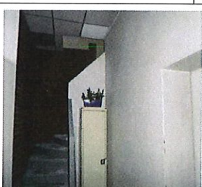
UNE NOUVELLE CAGE D'ESCALIER POUR SOLIHA SAINT OUEN APRES UN INCENDIE VOLONTAIRE ; ANDRE CLERET
