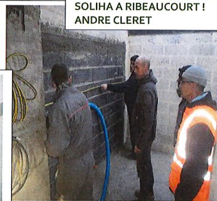
ON PREND LES MESURES AU CHANTIER DE MENESLIES / CHRISTOPHE LECUYER
