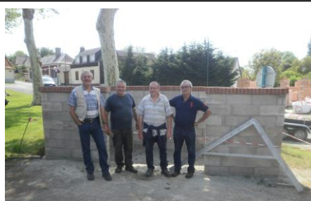
Local poubelle à VRON : la valse des poubelles sur la chaussée devrait disparaître grâce au chantier de MR DESMET
