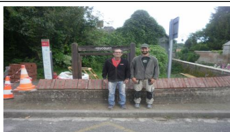
Mur de FRUCOURT : CHANTIER DE MR MAILLARD
