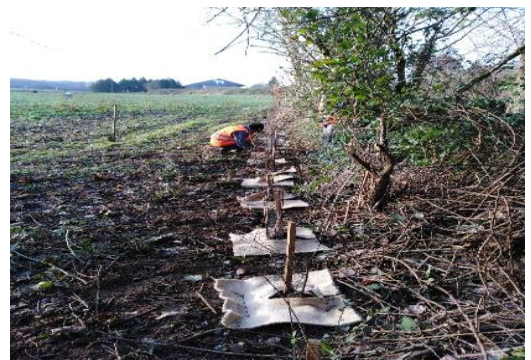
Une haie en plantation à LANCHES SAINT HILAIRE / Chantier de Mr VIGNERON
