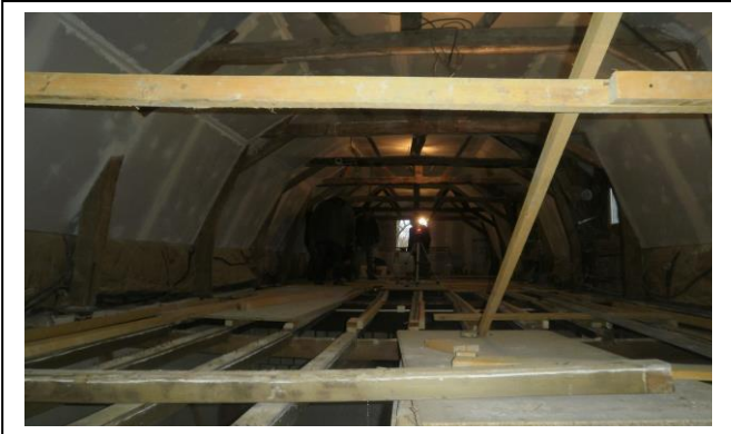
On a décortiqué une maison à RAINCHEVAL / Chantier SOLIHA de Mr MAILLARD
