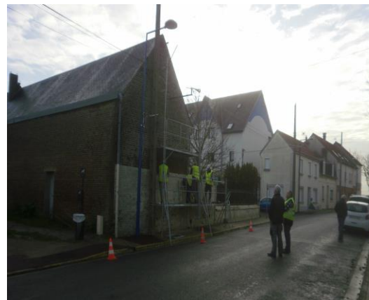
Le mur de la Maison MIGNON du CROTOY en phase de rejointoiment: chantier de Mr DUFETELLE
