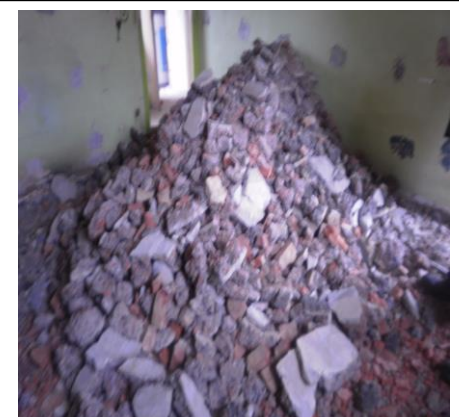
UN SUPERBE TAS DE GRAVAS POUR UN LOGEMENT SOLIHA A AIRAINES / CHANTIER DE LIONEL MAILLARD
